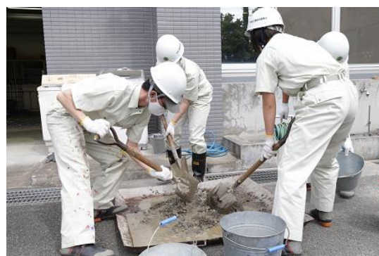
コンクリート実習
