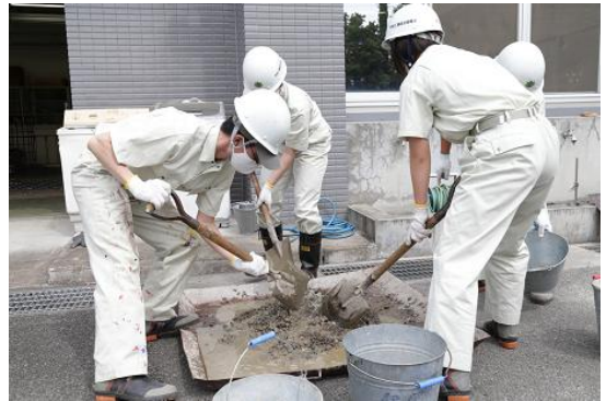
コンクリート実習
